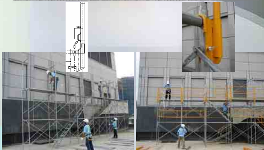
安全母索支柱工法
