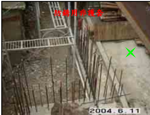
鋼筋裝護套或彎折防刺穿
