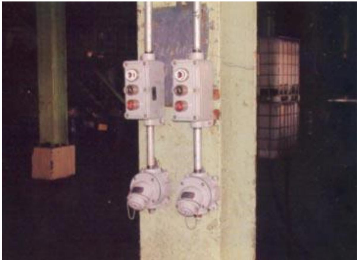
所使用之電氣設備（開關、電源插座）具有防爆性能或構造
