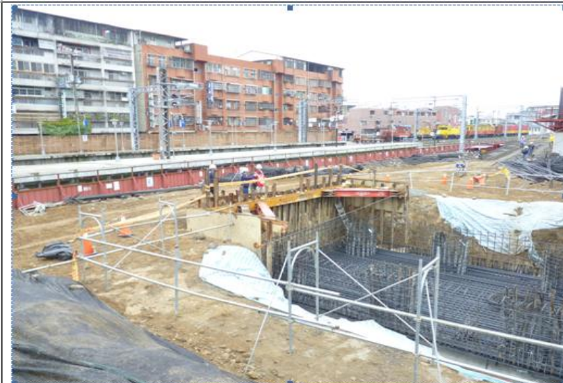
橋墩鋼筋籠因鋼索固定不足倒塌
