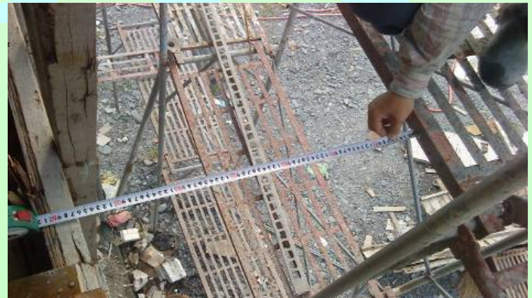
第三層施工架與建築物外模板之距離量測為72公分
