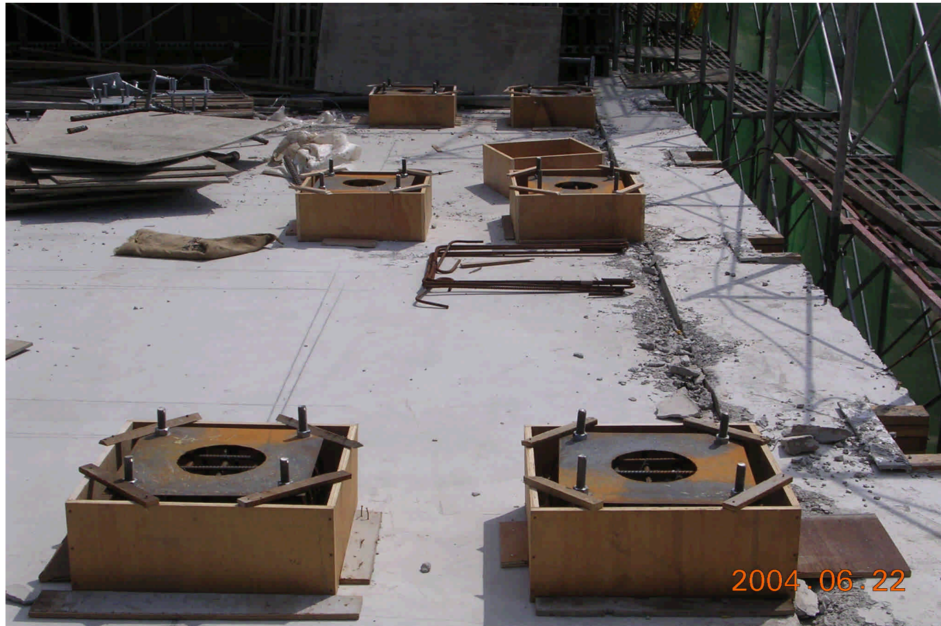
RC土墩灌漿組模情形
