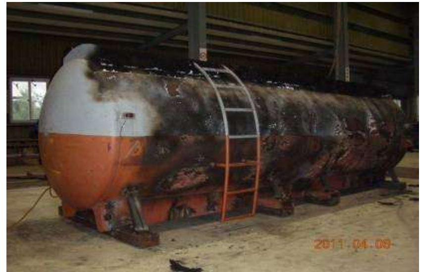
發生災害運輸槽
