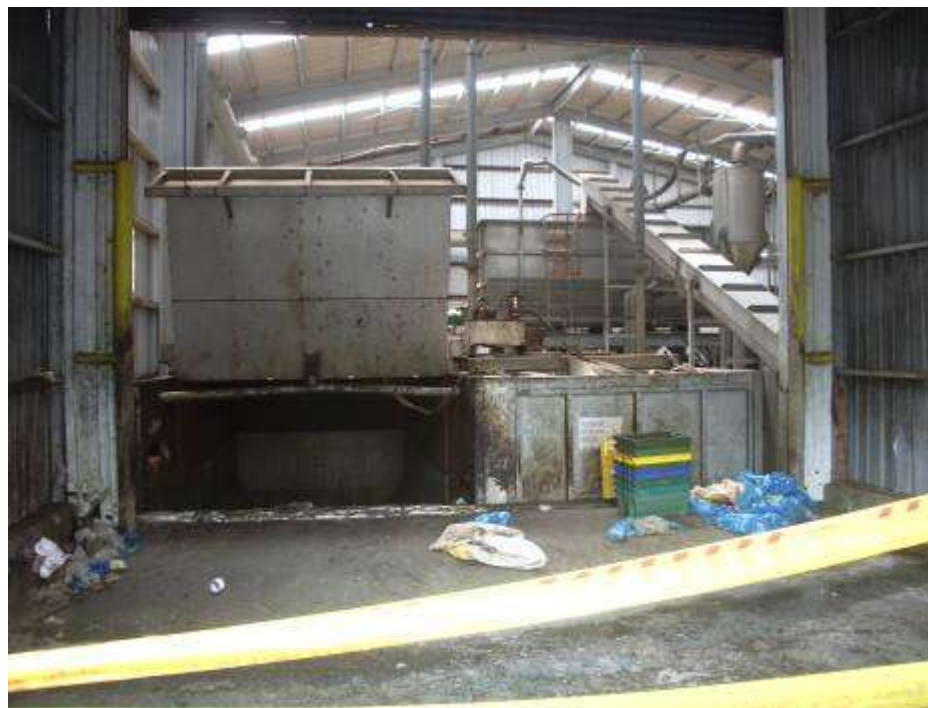
發生災害之骨雜 原料貯槽外觀
