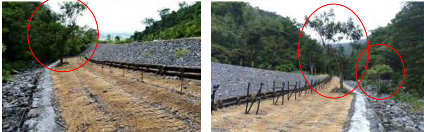
護岸以多孔隙高透水設計，採現地石材、木格框擋土牆、保留現地樹種、並配合植栽復育
