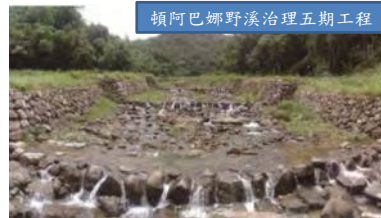
頓阿巴娜野溪治理五期工程
