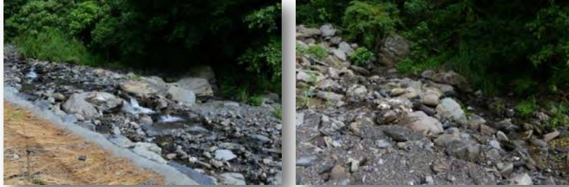
施工期間機具不下河床施工，完工後溪床保留自然原始風貌
