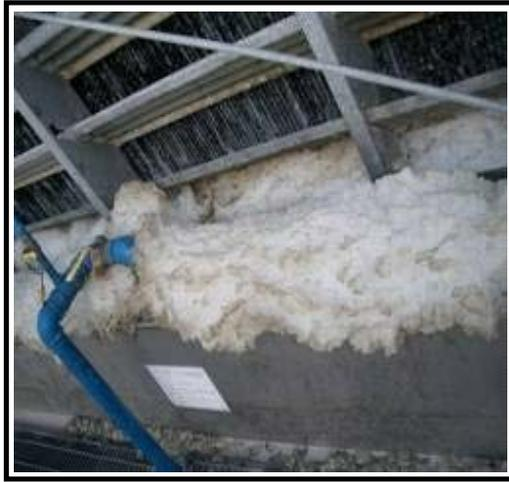
圖 1 冷卻水塔異常大量泡沫
